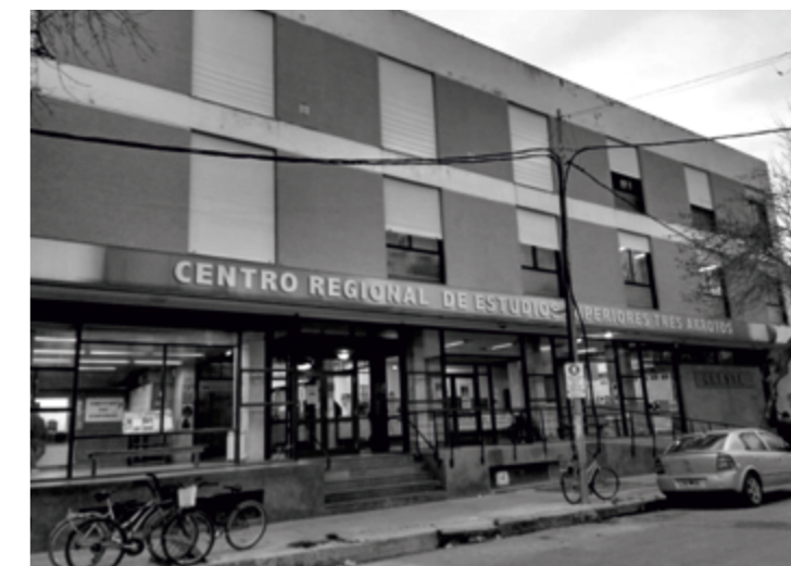
Fotos 1 y 2: exteriores de la sede CRESTA
