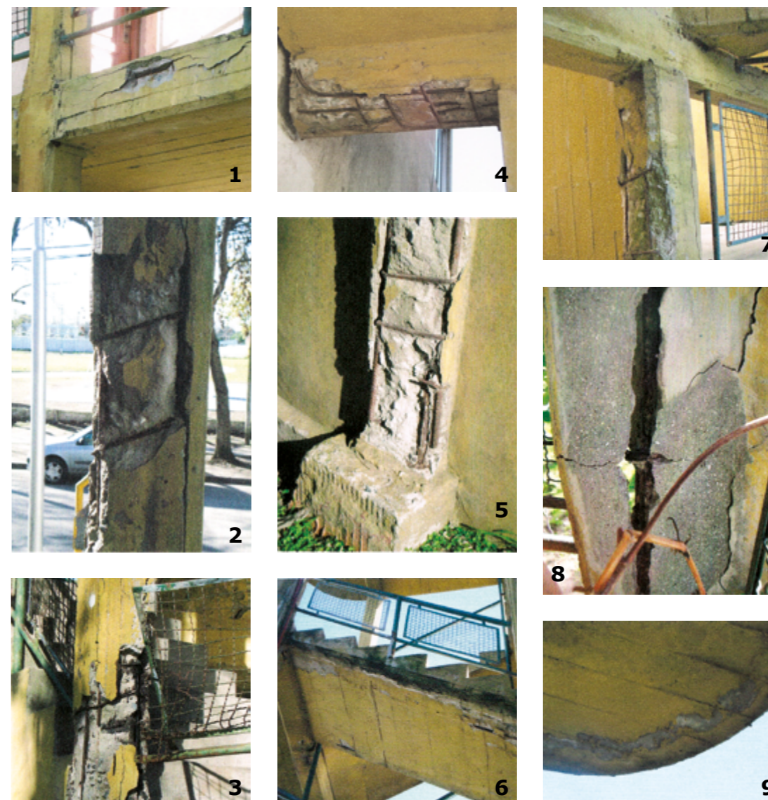
Foto 1 Losa y viga en escalera núcleo E1.
