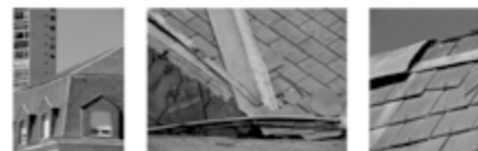
AJUSTE Y REPOSICIÓN DE ZINGUERÍA EN TRAMOS DESPRENDIDOS DE LIMATESAS PROVISIÓN Y COLOCACIÓN DE ZANJURAS EN TRAMOS FAL TANTOS O DETERIORADOS SEGÚN REDISEÑO DE PIEZA TIPO 28
