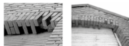
DESMONTE DE LOS ELEMENTOS Y RECUPERACIÓN DE LAS PIEZAS A REUTILIZAR RECONSTRUCCIÓN DE LOS MUROS DE LADRILLO - HIDROFUGADO
