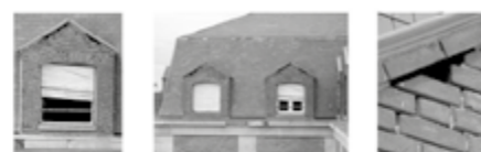
DESMONTE DE LOS ELEMENTOS Y RECUPERACIÓN DE LAS PIEZAS A REUTILIZAR RECONSTRUCCIÓN DE LOS MUROS DE LADRILLO - HIDROFUGADO
