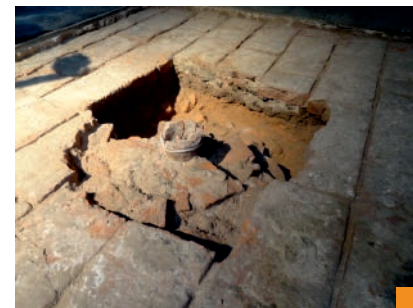
3. Vista del piso original, y posible localización de la pila bautismal con desagüe sobre el elemento que sobresale en el centro. El que al ser extraído, aparenta ser un caño de desagüe.
