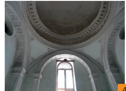
4. Interior de la capilla donde se visualiza parte de la cúpula, los arcos de sostén y los óculos laterales que se encuentran cegados.
