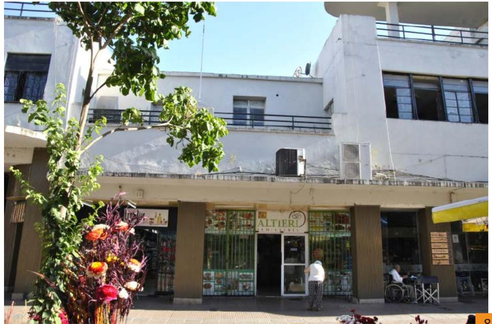
8. Agregado sobre terraza, faltante de protecciones y unidades exteriores sobre losas. Base de datos fotográficos propia (2018).
