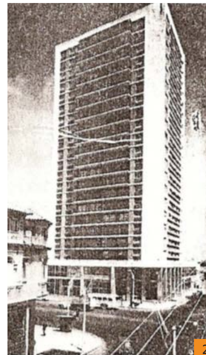
2. Imagen publicada en el Diario La Capital de Mar del Plata, donde se observa el recién construido Edificio Banco Popular Argentino. Diciembre 1958.
