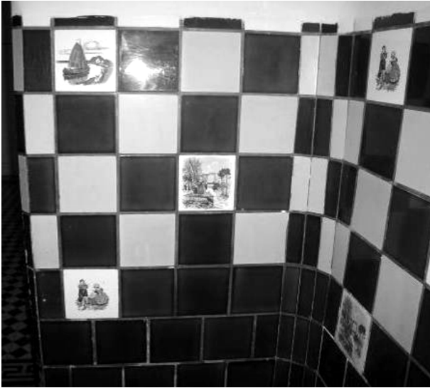
Muestra de un muro del Unzué revestido con azulejos sin sello de fábrica en su cara posterior. Mar del Plata, diciembre 2007.
