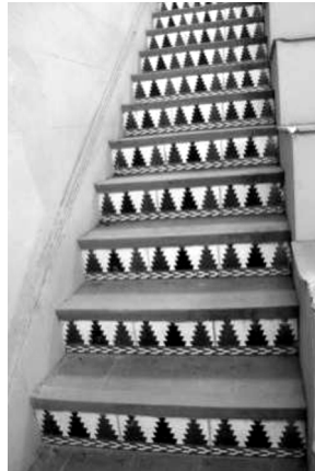
Contrahuella de escalera externa- Buenos Aires 400.
