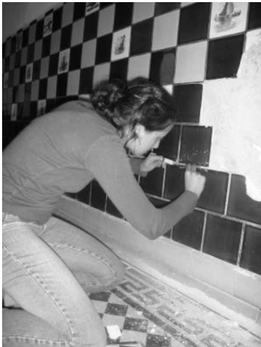
Se utilizan herramientas especiales con superficie de contacto reducida. Se procede a la limpieza del material de junta, luego de esta acción el azulejo puede ser recuperado con facilidad.
