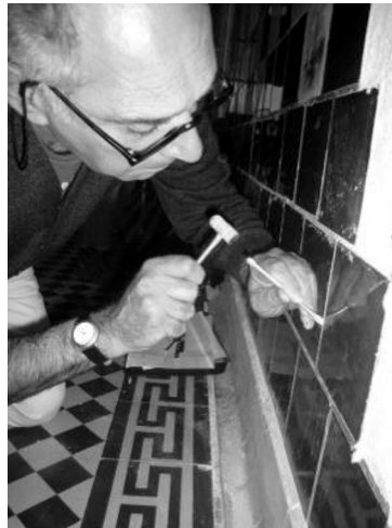
Se utilizan herramientas especiales con superficie de contacto reducida. Se procede a la limpieza del material de junta, luego de esta acción el azulejo puede ser recuperado con facilidad.
