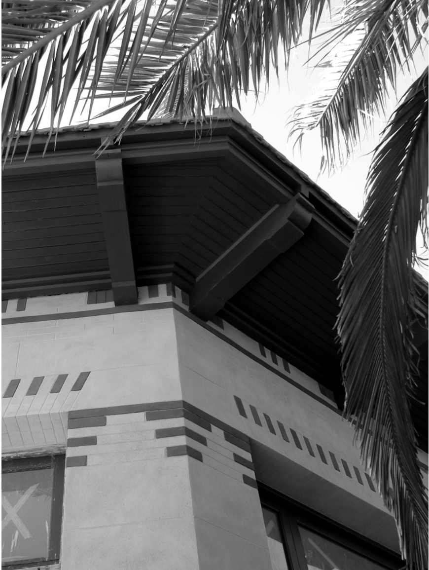
Aspectos de la restauración del Instituto Saturnino Unzué, detalle bajo cornisa.
