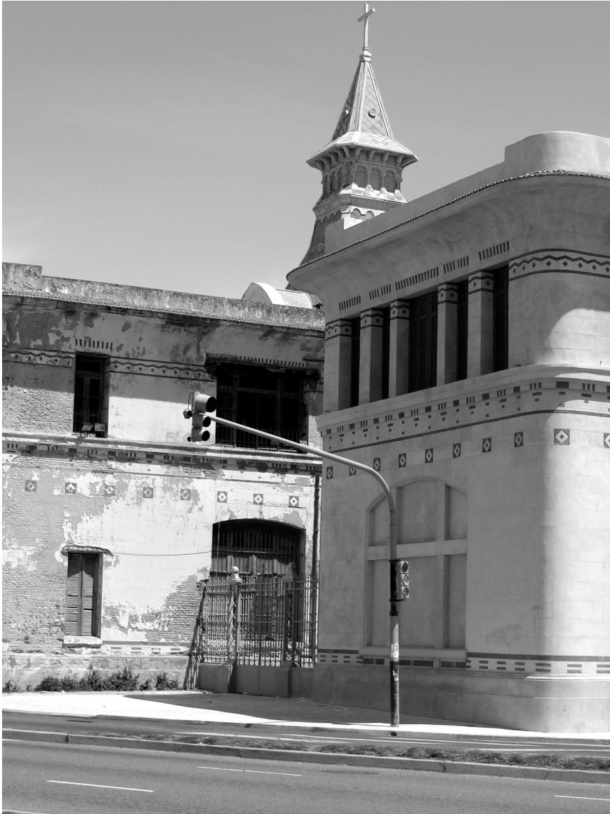
Aspectos de la restauración del Instituto Saturnino Unzué.
