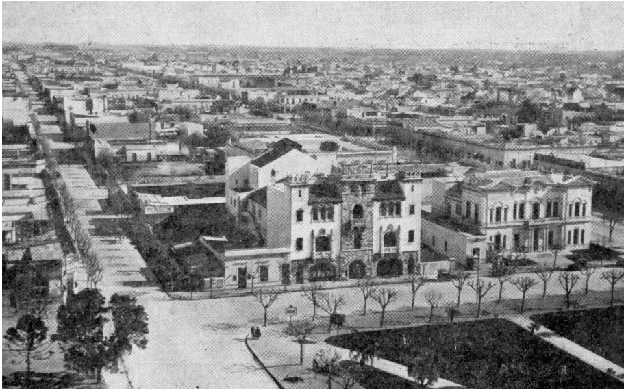
Vista marplatense, la antigua Municipalidad y el Teatro Colón nuevo.
