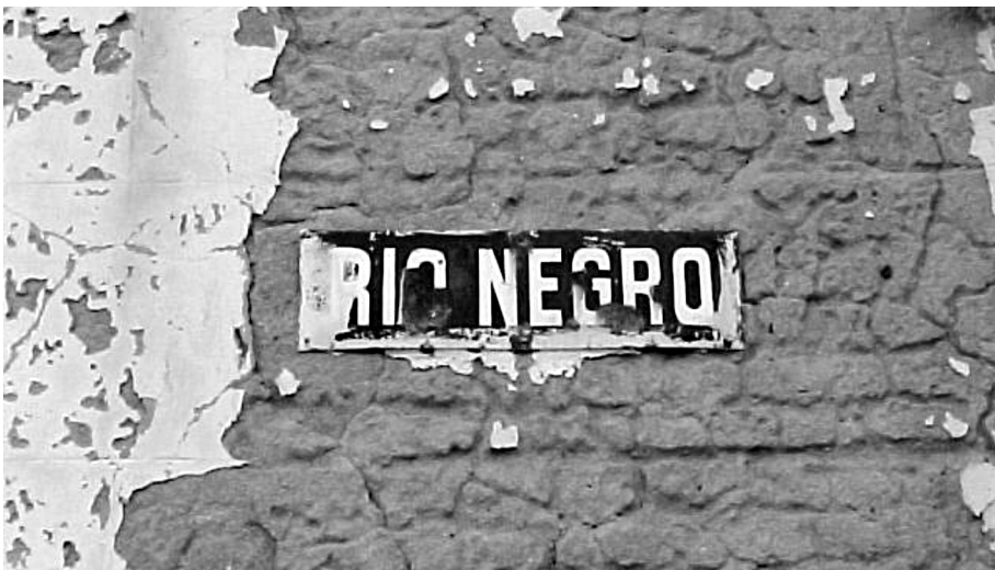
Imágenes de la fachada previas a la restauración.
