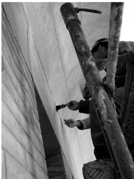
Proceso de obra: ejecución de buñas.
