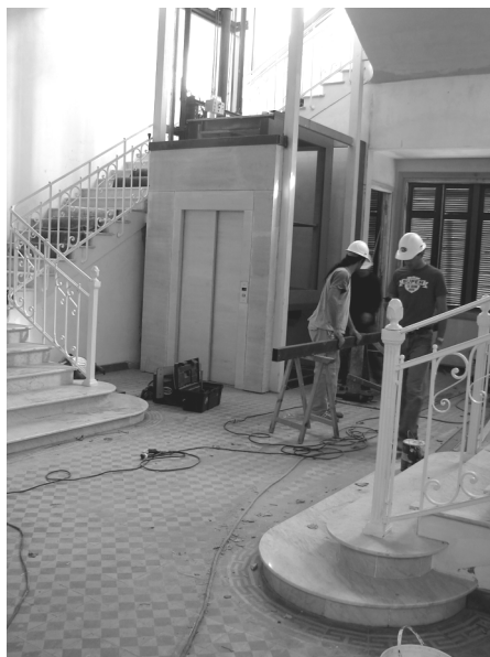
Proceso de obra, la ejecución de molduras con moldes y reglas.
