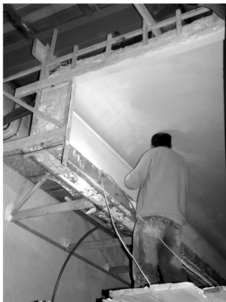
Proceso de obra: ejecución de buñas.
