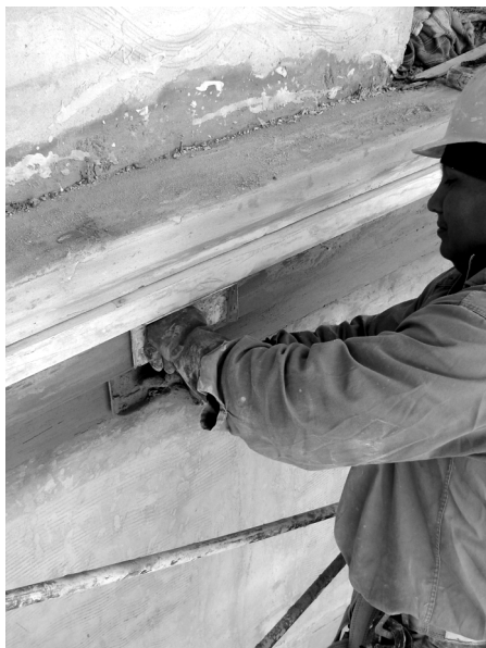
Proceso de obra, la ejecución de molduras con moldes y reglas.
