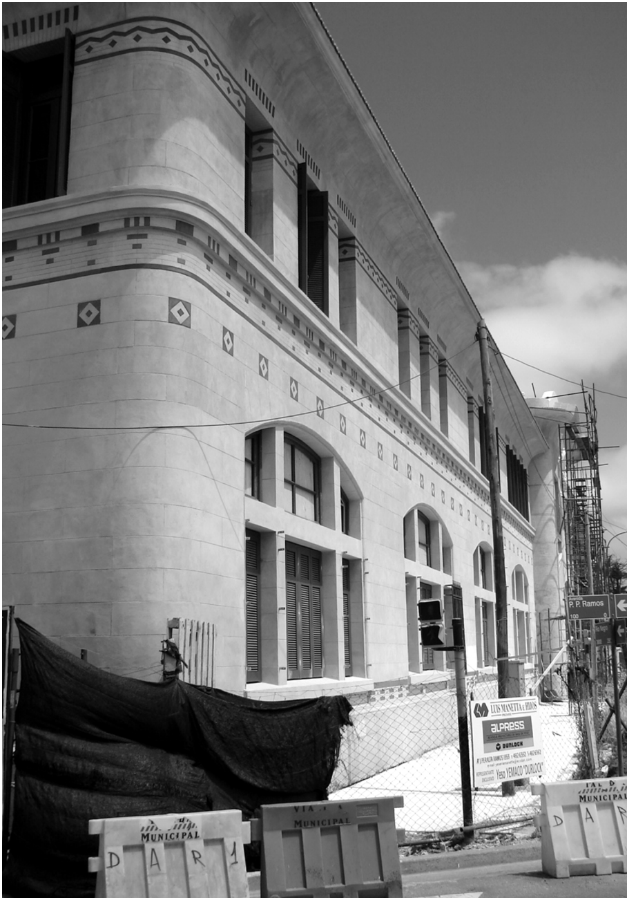
Imagen del paño terminado, pabellón Río Negro.
