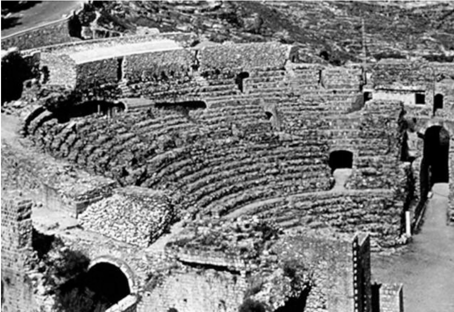
Imagen 7 - Ruinas romanas de Sagunto antes de la intervención
