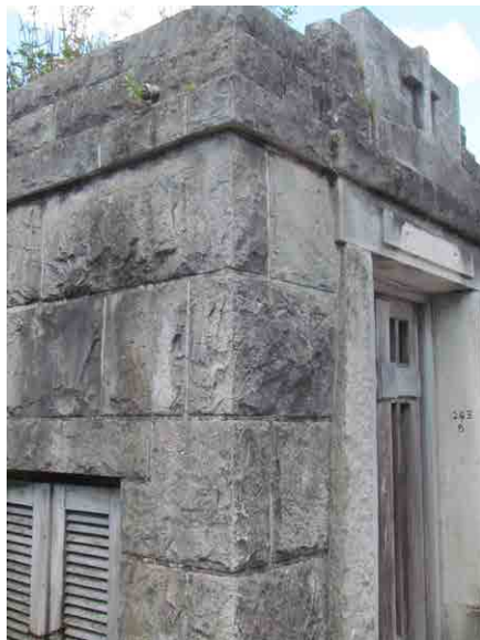
Foto 2 – sup. que puede ser intervenida con hidrolavado
