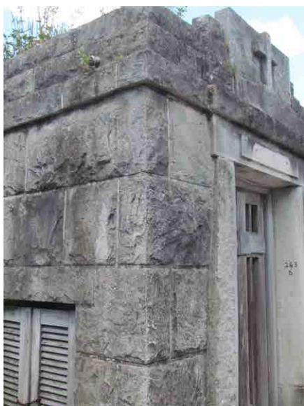
Foto 3 – diferentes trabajos en piedra
