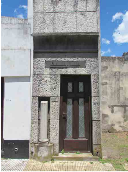
Foto 1. Presencia de suciedad por absorción
