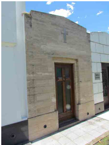
Foto 1 – Revestimiento de mármol travertino
