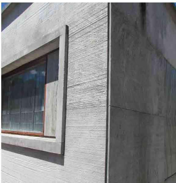
Foto 6 – Trabajos exteriores en travertino
