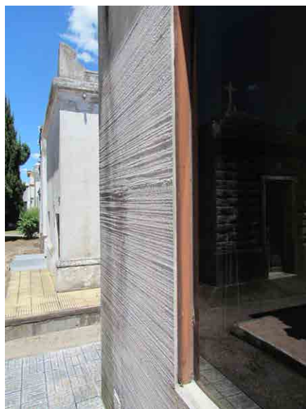
Foto 4 – terminación exterior de bóveda
