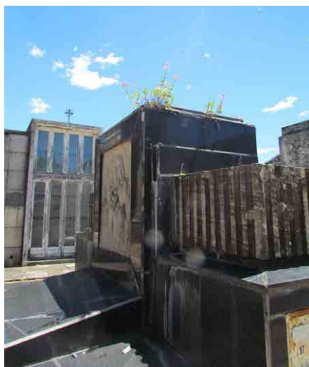
Foto 4 - especie arbórea en junta de mármol
