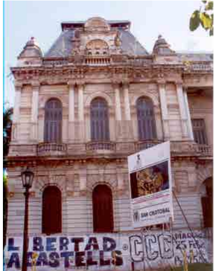
Vistas de diferentes sectores de fachadas que muestran el estado previo a las decisiones de intervención. Pintura, desprendimiento, crecimiento de especies vegetales, entre otros. Fuente F.P.B.
