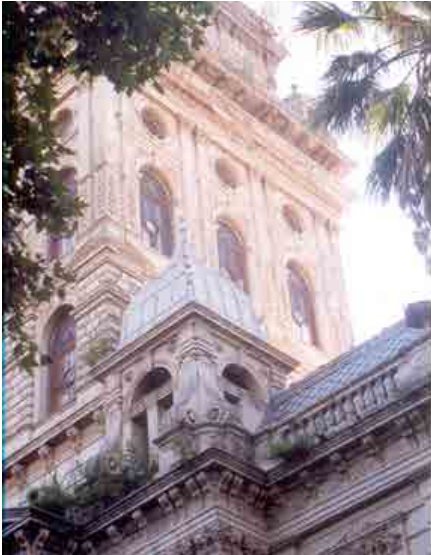
Vistas de diferentes sectores de fachadas que muestran el estado previo a las decisiones de intervención. Pintura, desprendimiento, crecimiento de especies vegetales, entre otros. Fuente F.P.B.
