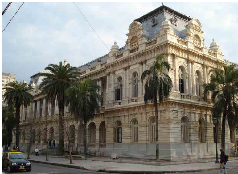
Imagen del sector Pabellón de esquina calles Moreno y Córdoba ya restaurado. Aprox 2017 . Fotografía F.P.B.
