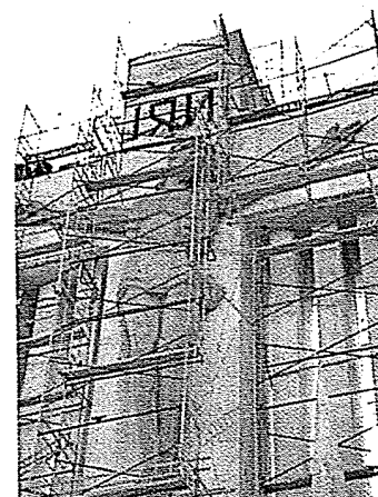
Proceso de obra, los andamios. Portal del Cementerio de Laprida. Provincia de Buenos Aires.
