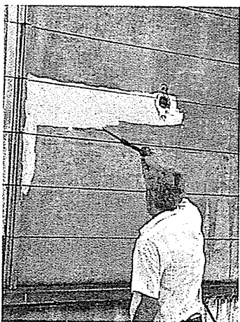
Prueba de hidrolavado en la fachada del Palacio Municipal de Bragado, Provincia de Buenos Aires
