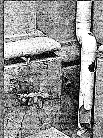
Craquelado con humedad e incorporación de elementos ajenos a la fachada que producen mayor humedad.
