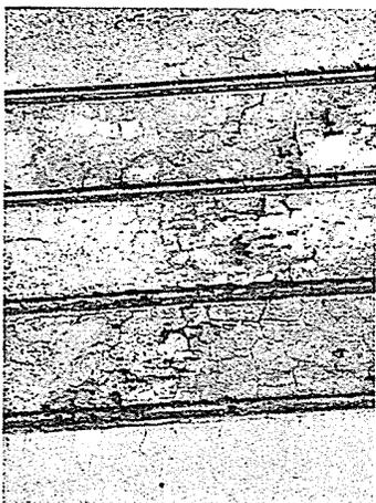
Pérdida del material de revestimiento por disgregación y decapación
