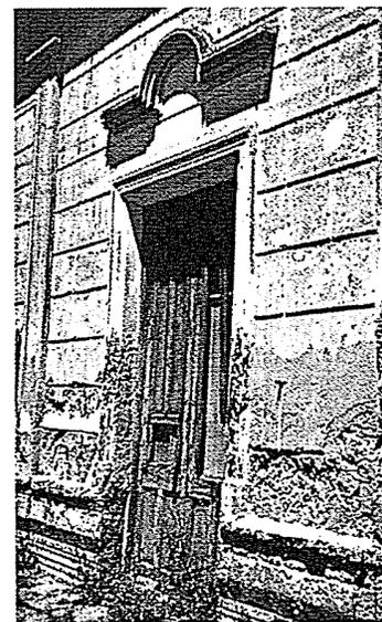
*Pérdida del material de revestimiento por disgregación y decapación.*
