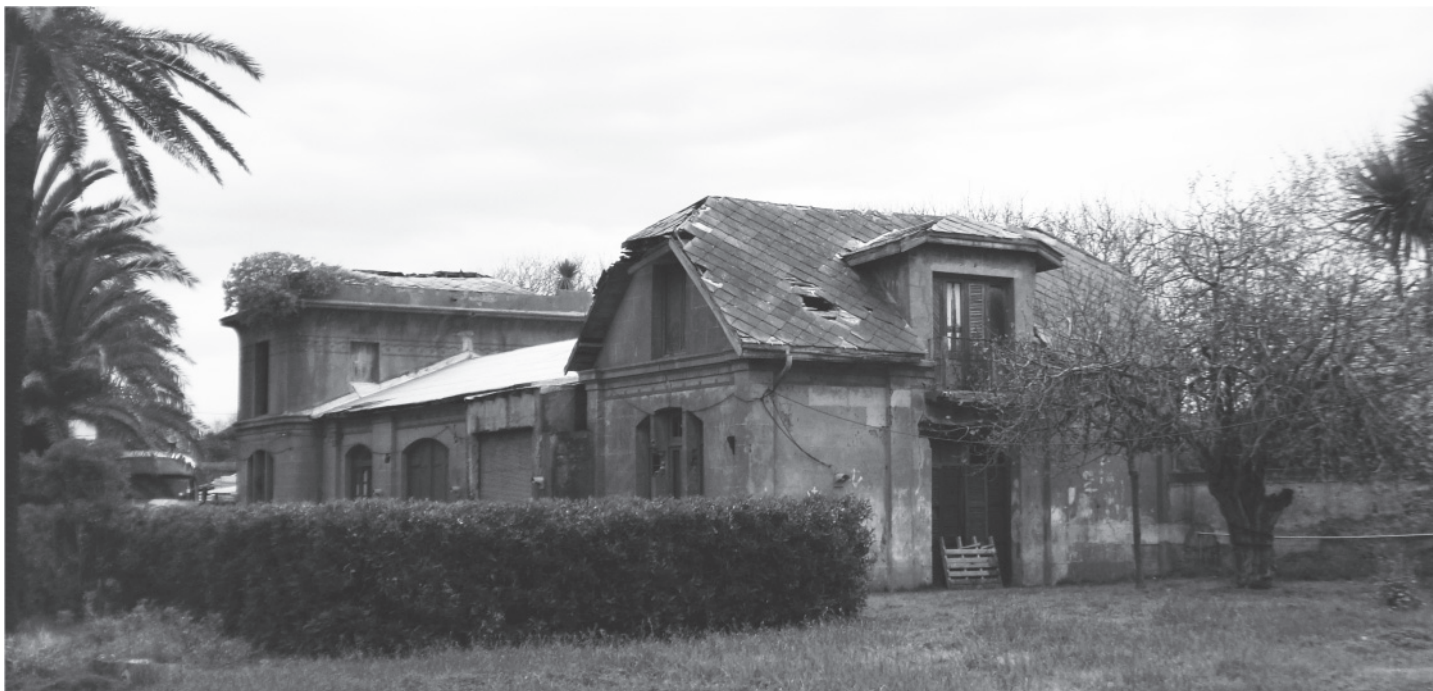
Estado actual del edificio de las cocheras. Fuente Archivo personal F.P.B..
