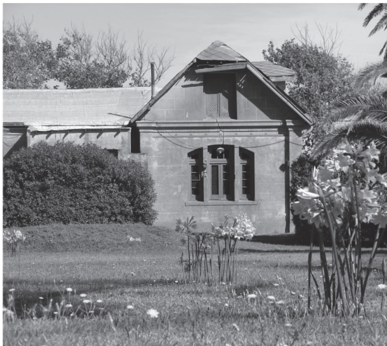
Estado actual de un sector edificio de las cocheras. Fuente Archivo personal FRB.
