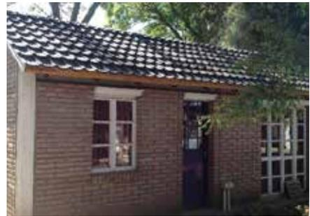
**Figura 8.** Foto actual del prototipo con tejas de materiales reciclados
