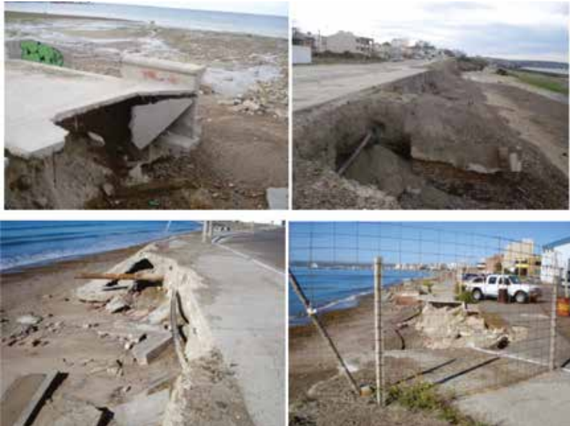
Figura 4. Daños registrados por eventos de tormentas pluviales y mareas extraordinarias (2013 y 2016) en el frente acantilado norte de Puerto Madryn. Fuente: A. Monti, este artículo.
