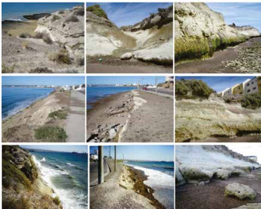
Figura 2: Procesos de erosión natural e inducida en el frente acantilado del Barrio Barrancas Norte (PuertoMadryn). Fuente: A. Monti, este artículo.
