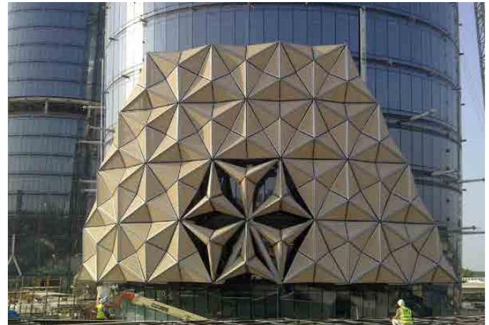
Fig 5: Piezas adaptativas para optimizar el rendimiento de la Torre Al Bahar en Abu Dhabi del año 2009-2012 diseñado por Abdulmajid Karanouh Associate Architect
