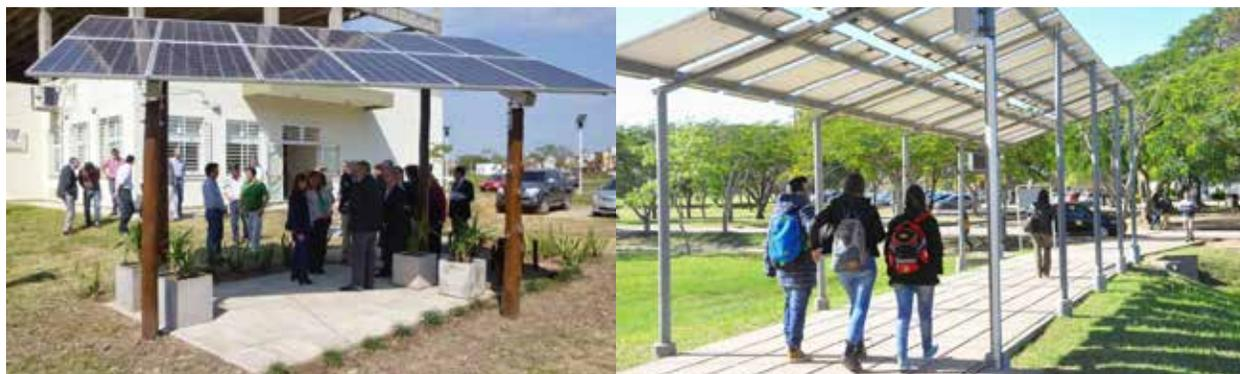
Figura 1: Instalación de un Patio solar en la Universidad Nacional de Nordeste, Resistencia, Chaco con 3 kWp de generación, y Pérgola solar fotovoltaica experimental que genera e inyecta energía eléctrica a la red del edificio de Ingeniería en el campus Deodoro Roca, FaCENA, Corrientes, con una potencia nominal de 6720 Wp. Fuente: [www.iresud.com.ar](http://www.iresud.com.ar)
