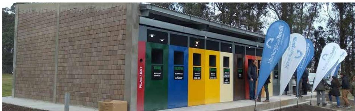
Fig. 6 Punto de acopio de materiales reciclables realizado con bloques con agregado de polímeros. Punto Limpio - Estación Hípico, Tandil
