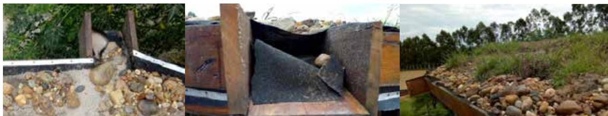
Fig. 5, 6 y 7 – Fuente propia. Detalles de desagües pluviales obstruidos, canaleta y perímetro de la cubierta.
