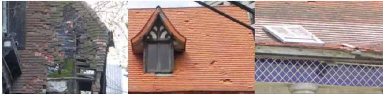
Fig. 7 Una revisión periódica de los elementos de anclaje permitirá diagnosticar su estado de integridad y advertir el posible inicio de procesos de corrosión que puedan afectar a los mismos. Fuente: fotografías propias.
