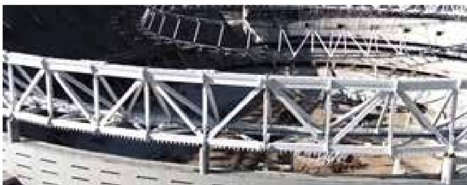
Fig. 19: Cercha de acero. Anillo de Compresión.
