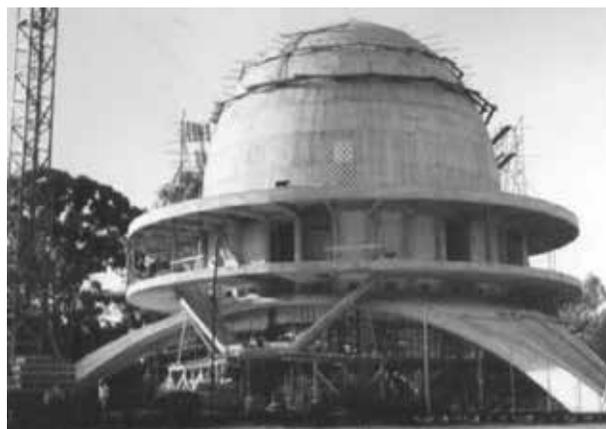
Fig. 5. Encofrados. Fase de construcción del Planetario
