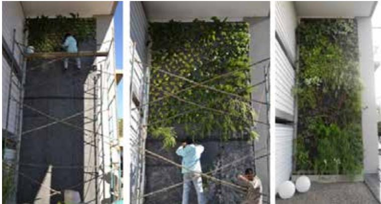
Fig. 2: Proceso de construcción del muro verde. Fuente: Empresa Siempre Verde, diseño de Jardines.
