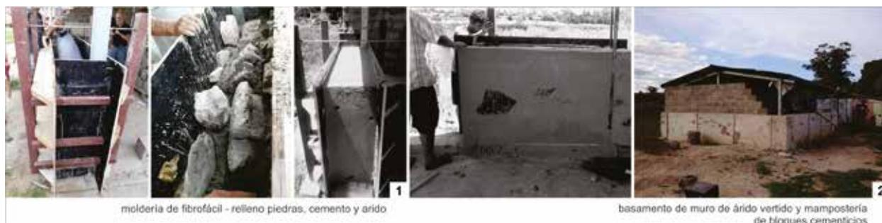
Figura 8: Muro de árido vertido. Fuente: elaboración propia
