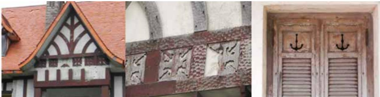
Fig. 6 La falta de mantenimiento y/o la incorrecta aplicación de pinturas de protección, sumado al alto contenido de humedad, también favorece la pudrición de los elementos en madera. Fuente: fotografías propias.
