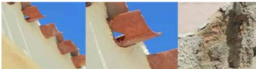
Fig. 4 Alguno de los efectos producidos por la “agradable” brisa costera cargada con partículas en suspensión.
