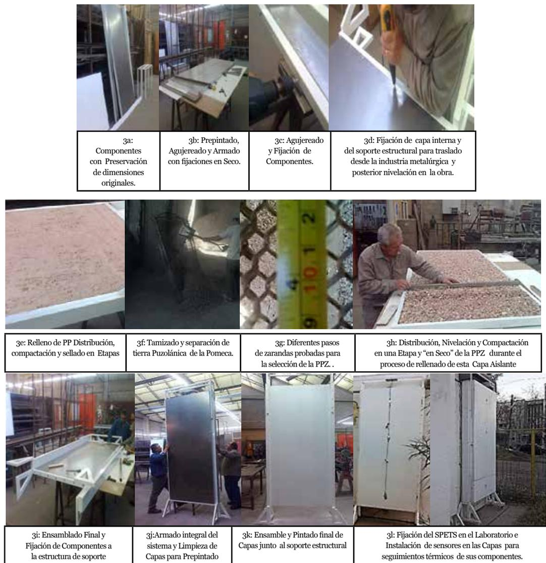
Figura 3: Desarrollo del estudio de Prefabricación e Instalación en obra. Fuente: Elaboración del autor.
