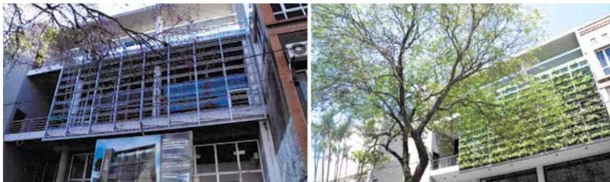
Fig. 4: Fachada del edificio. A la izquierda durante el proceso constructivo y a la derecha el resultado final. Fuente: Archivos del autor del proyecto, Arq. Gustavo Barrios D’Ambra.
