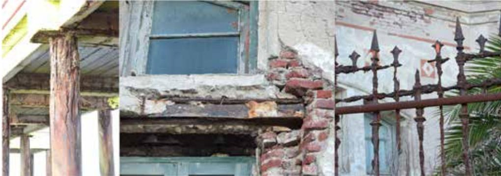
Fig. 5 La falta de programas de mantenimiento preventivo puede desencadenar procesos patológicos que pongan en riesgo la seguridad pública o la integridad estructural de las construcciones, así como su ornato. Fuente: fotografías propias.
