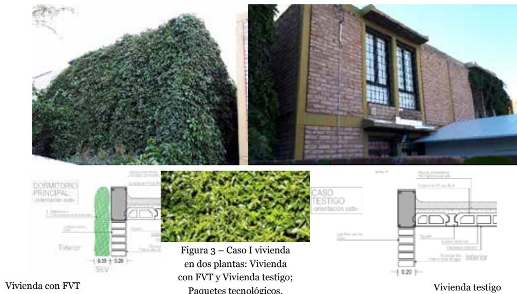
áreas sísmicas: estructura de hormigón armado y mampostería de ladrillo visto. Las cubiertas son planas, conformadas por losas de hormigón alivianadas, aisladas térmica e hidráulicamente. Una de ellas presenta el sistema de FVT en la fachada interna de la vivienda orientada al Este y en la fachada lateral orientada al norte. La FVT está conformada por una enredadera -especie *Parthenocisus Quinquifolia*- de un espesor promedio de 40cm que cubre el 100% de las fachadas. Ver Fig. 3.
