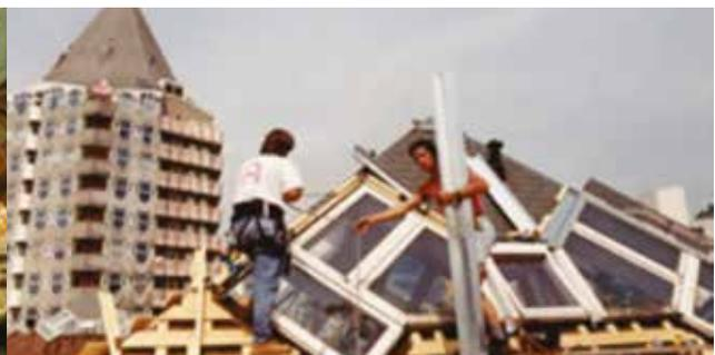
Fig. 9 - Esqueleto de madera Casa Cubo. Fig. 10. Detalle de techo.
