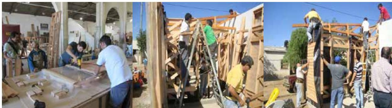
Fig. 4, 5 y 6: Imágenes del proceso: Armado de matrices y componentes. Montaje en la obra.
