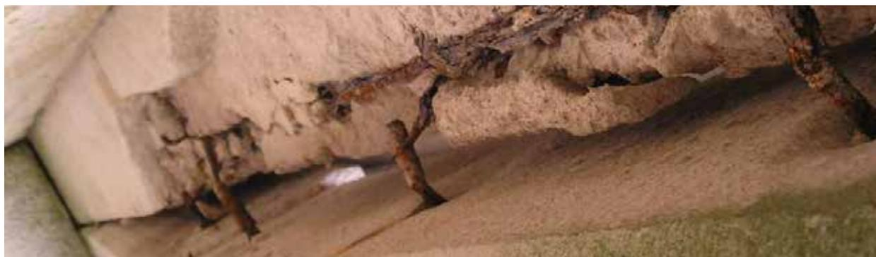
Figura 2- Corrosión de armadura y anclajes de sujeción de piedras de la cornisa.
