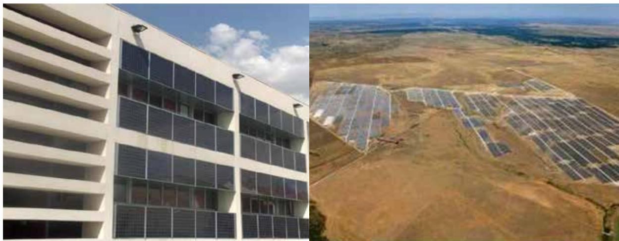
Figura N° 2: sistemas interconectados a Red, PV in buildings en el Centro Cívico “el Cerro” (Coslada-Madrid) y las Centrales de Potencia. Trujillo, Extremadura, Spain-Elecnor. Fuente: [www.iresud.com.ar](http://www.iresud.com.ar)
