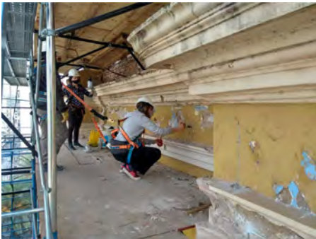
Cateos y análisis de muestras en laboratorio. Fotografías de autoras
