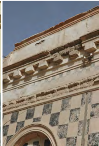
Fig. 11. Detalle de cornisa
