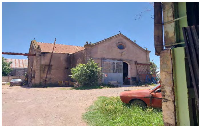
El edificio original de la Sociedad Rural incorporado a las instalaciones de la ex Fábrica EIMA Fotografías de la autora, noviembre de 2022
