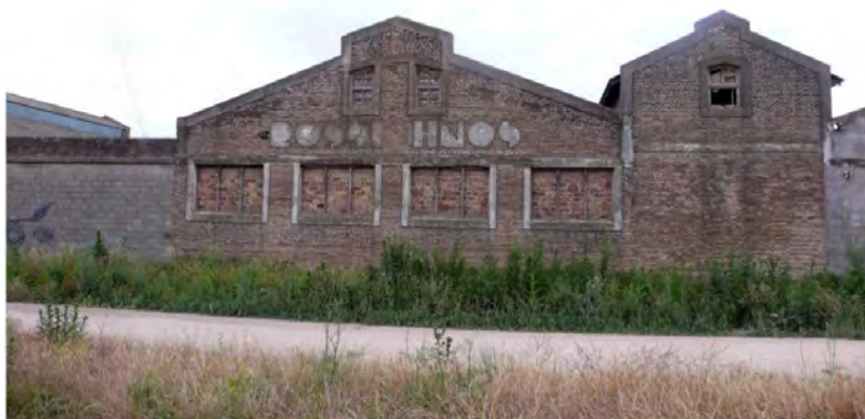
Construcción de la fábrica Rossi. Foto histórica archivo Museo Mulazzi. Galpones vistos desde las vías del ferrocarril – Foto de autora, noviembre 2022.
