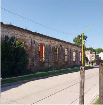
Fabrica Istilart /esquina Sarmiento y FFCC hacia calle Fotografía de autor (2022)
