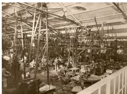
Fabrica Istilart / sector productivo / Traslado de fuerza motriz por poleas - Archivo fotográfico coleccionista Andrés Errea
