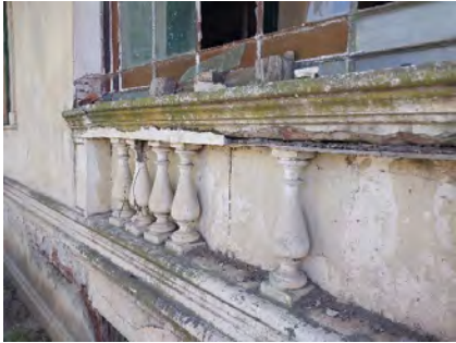
Casa Istilart / Acceso principal a la vivienda -Piezas faltantes balaustre de acceso Carpintería de hall de acceso con faltantes – Foto del autor (2022)
