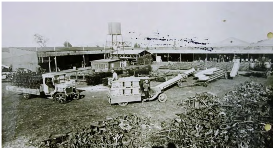
Playa de maniobras – Materiales de fundición, transporte de elementos y materia prima Archivo fotográfico particular del coleccionista Andrés Errea
