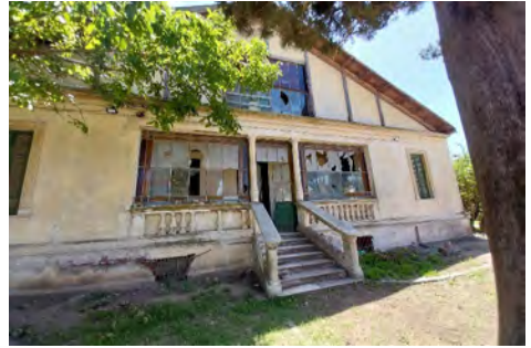
Casa Istilart / Acceso principal a la vivienda -Piezas faltantes balaustre de acceso Carpintería de hall de acceso con faltantes – Foto del autor (2022)
