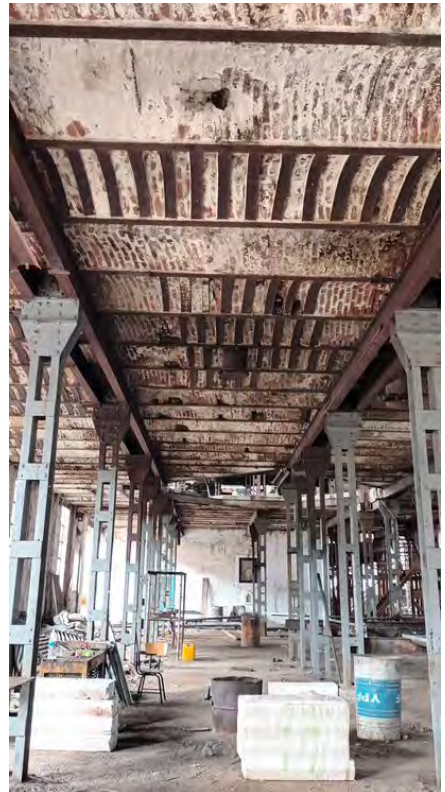
Fig.9 vista de los entresijos laterales y su resolución constructiva. Fig. 10 Interior de la nave transversal a las 3 de 1916 donde se encontraban las principales maquinarias. (fotografías de la autora)
