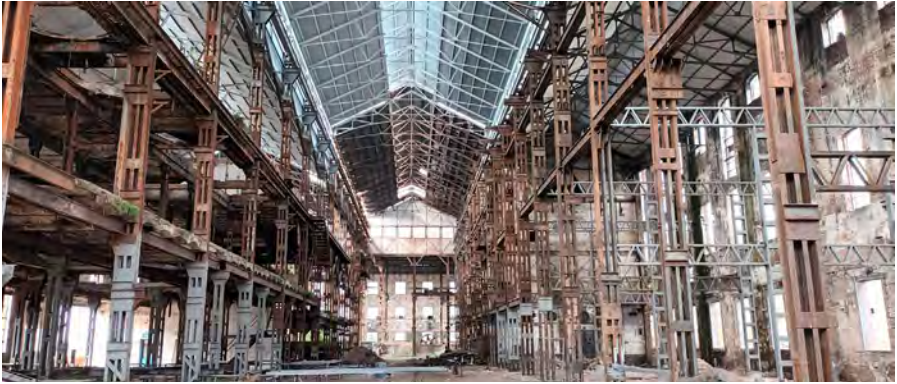
Fig.6 Interior de las naves de 1916 (fotografía de la autora)
