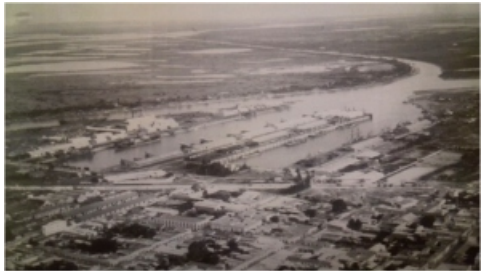
Fig. 8. Imagen aérea del puerto hacia en canal de acceso 1926. Fuente: Archivo General de la Provincia de Santa Fe.
