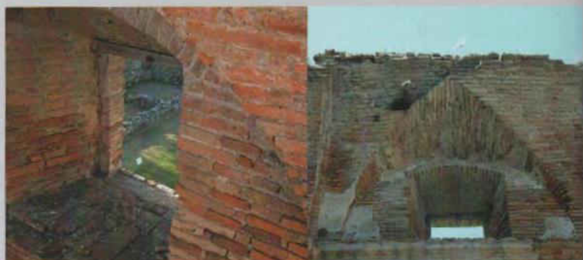
Figura 3.17 Vano de jambas y dintel abocinado en Capilla Calera de las Huérfanas, Carmelo.
