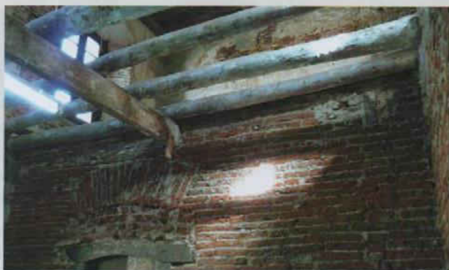
Figura 3.22 Troncos de palmera empleados en la Casa de Lecocq, actual sede de Cooperativa de viviendas COVICIVI, Ciudad Vieja.
