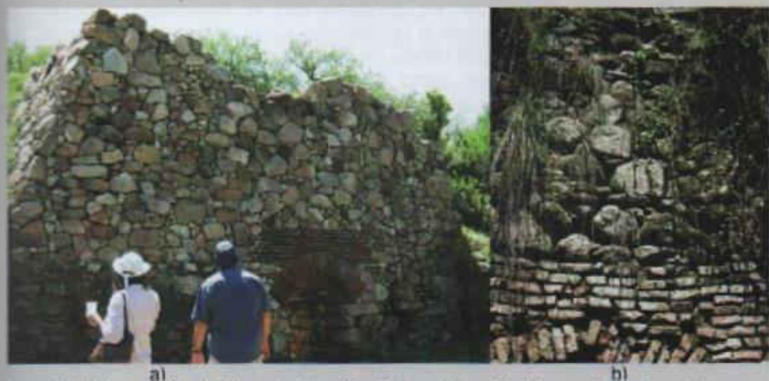
Figura 2.11 Hornos de cal, Estancia Jesuítica Calera de las Huérfanas, Carmelo; a) Paramento exterior de uno de los Hornos de cal, b) Vista de la pared interior en ladrillo y piedra.
