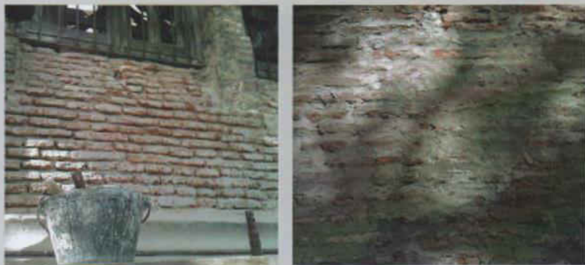
Figura 6.14 Reconstrucción del mortero de junta. Edificio Asilo Larrañaga. Montevideo. 2011.
