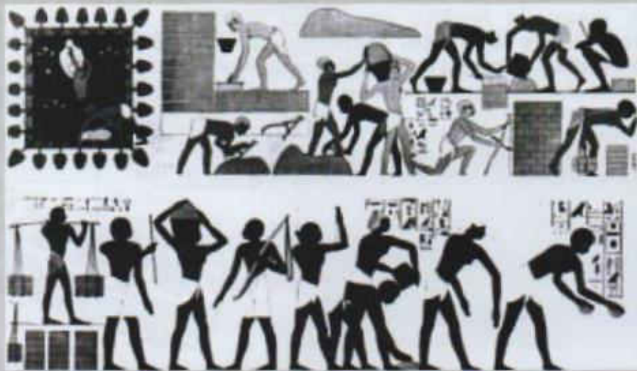
Figura 1.3 Esclavos de Tebas construyendo con ladrillos. Fuente: F. Casinello, 1960.
