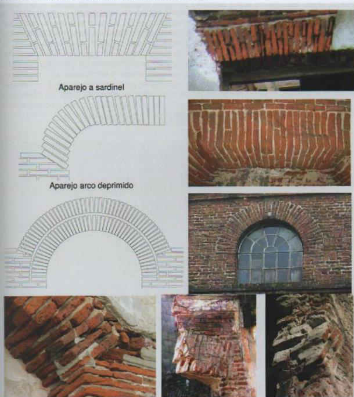
Figura 3.19 Aparejo de las diferentes variantes de dintel.
