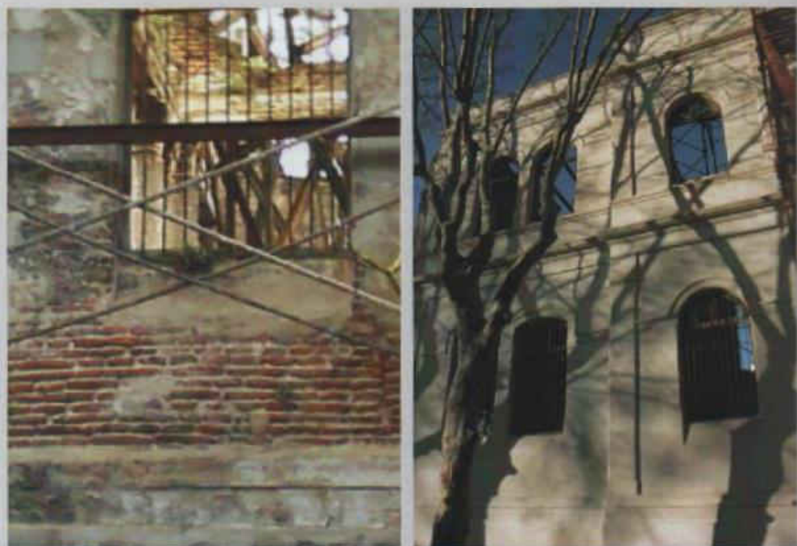
Figura 6.8 Recomposición de las capas protectoras de revoque. Portal de Rabú, Asilo Larrañaga. Montevideo. 2011
