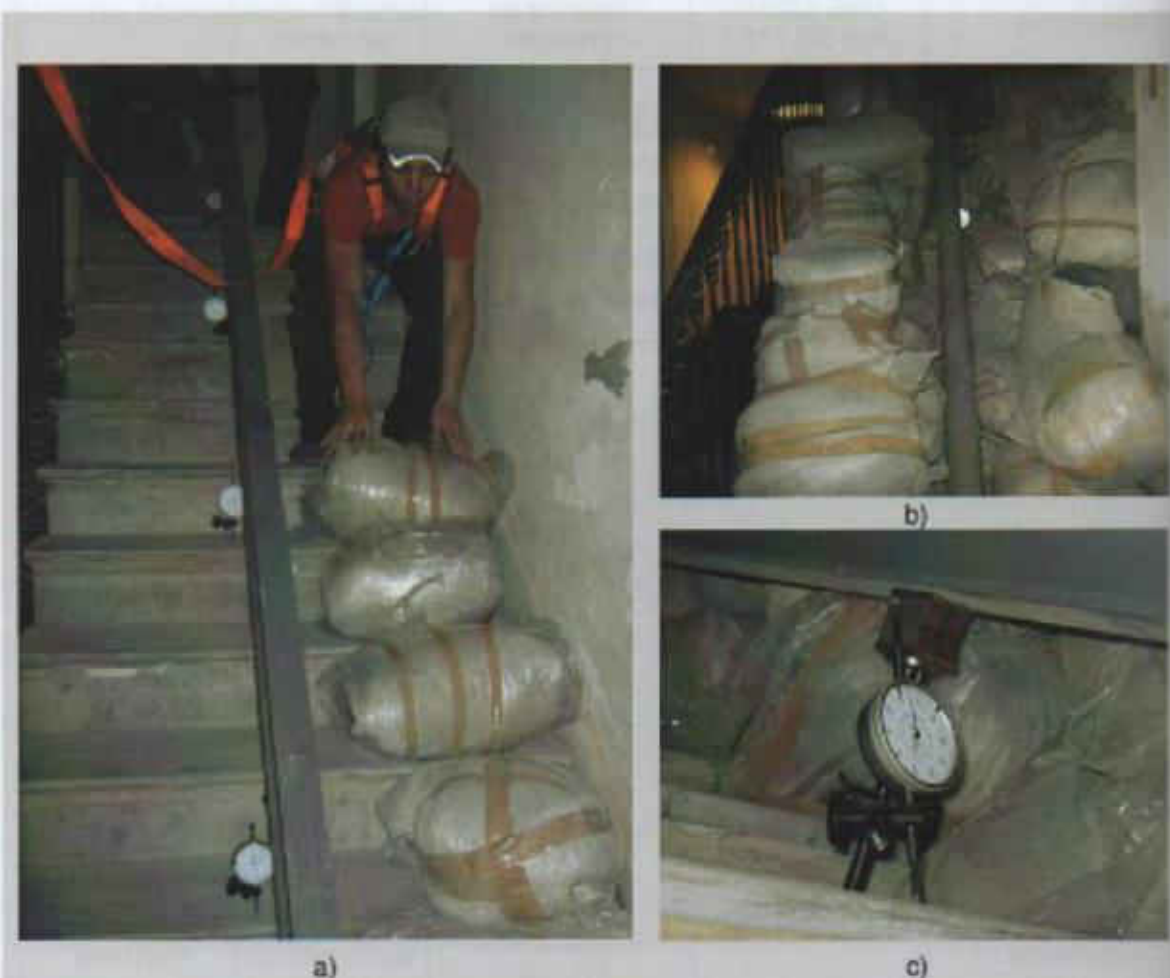
Figura 5.16 Ensayos sobre unidades constructivas in situ : a) Colocación de carga muerta (bolsas de arena) en un lado del tramo de escalera, b) Carga total aplicada, c) Detalle de la colocación del flexímetro adosado a perfil independiente.
