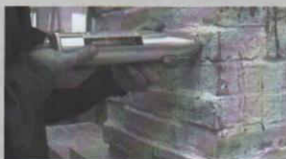
Figura 5.23 Aplicación del esclerómetro para analizar la homogeneidad de respuesta del muro.
