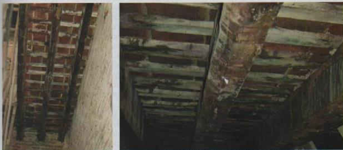
Figura 3.31 Entrepiso de estructura de madera y ladrillos. Vista de la cara inferior, vivienda unifamiliar, Ciudad Vieja de Montevideo.
