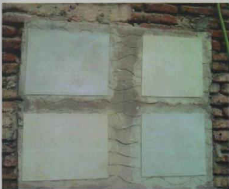
Figura 6.9 Recomposición de las capas protectoras de revoque. Pruebas de color, textura y terminación. Portal de Rabú, Asilo Larrañaga, Montevideo, 2011.
