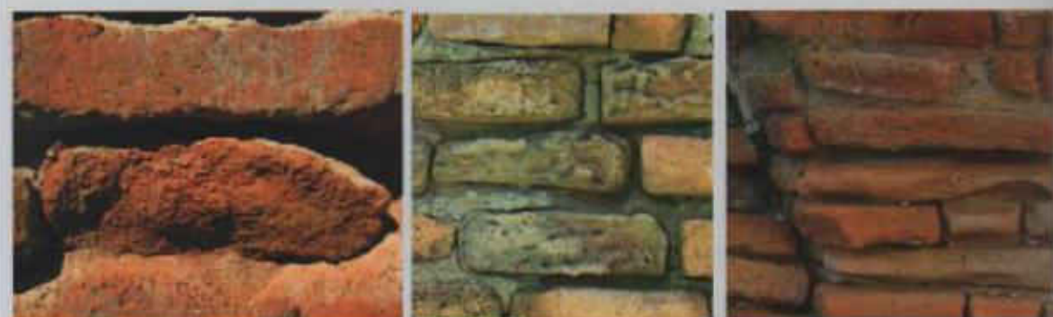
Figura 5.2 Patología por pérdida de material: a) Disgregación del mampuesto y erosión del mortero, b) Picado del mampuesto, disgregación y abrasión del mortero c) Erosión por abrasión del mampuesto y disolución del mortero.
