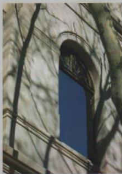
Figura 6.9 Recomposición de las capas protectoras de revoque. Pruebas de color, textura y terminación. Portal de Rabú, Asilo Larrañaga, Montevideo, 2011.
