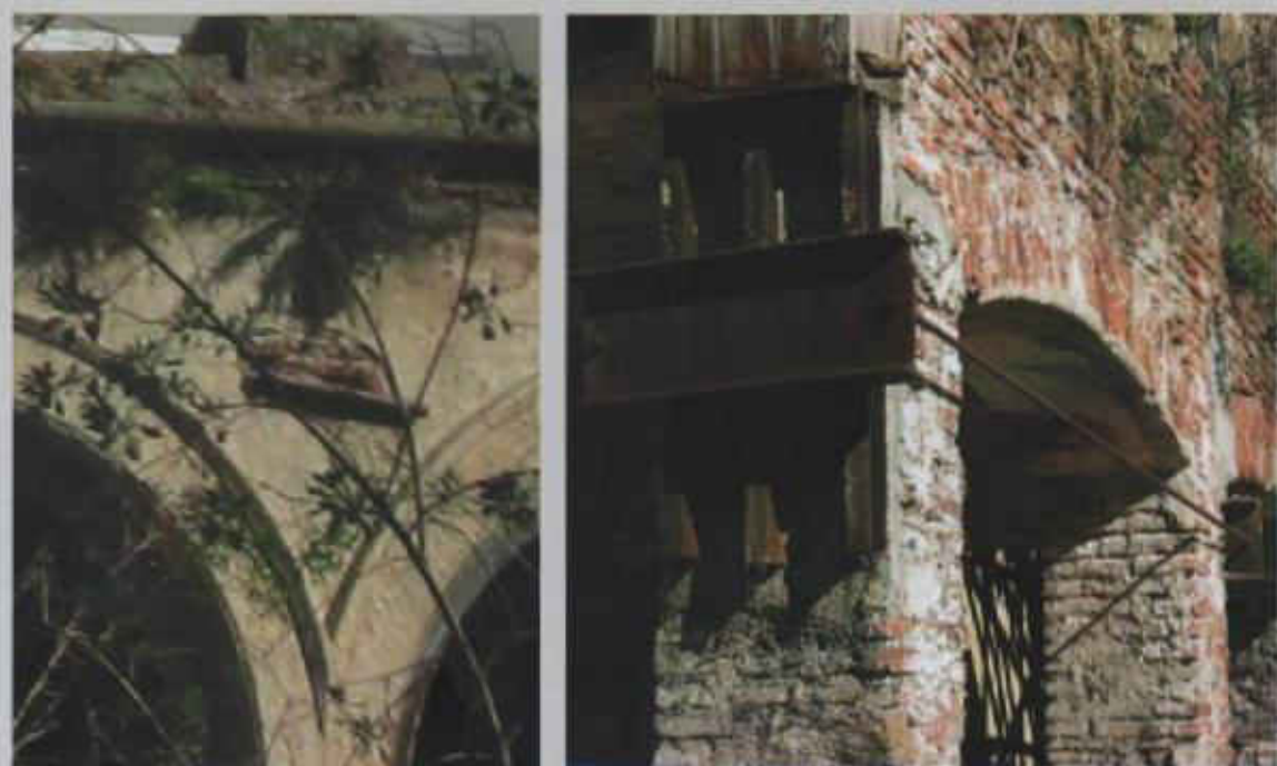
Figura 6.21 Refuerzo estructural exterior: tirantes metálicos provisionales para evitar colapso y absorber empuje desestabilizador en arco extremo de galería inferior. Edificio Asilo Larrañaga, Montevideo, 2011.
