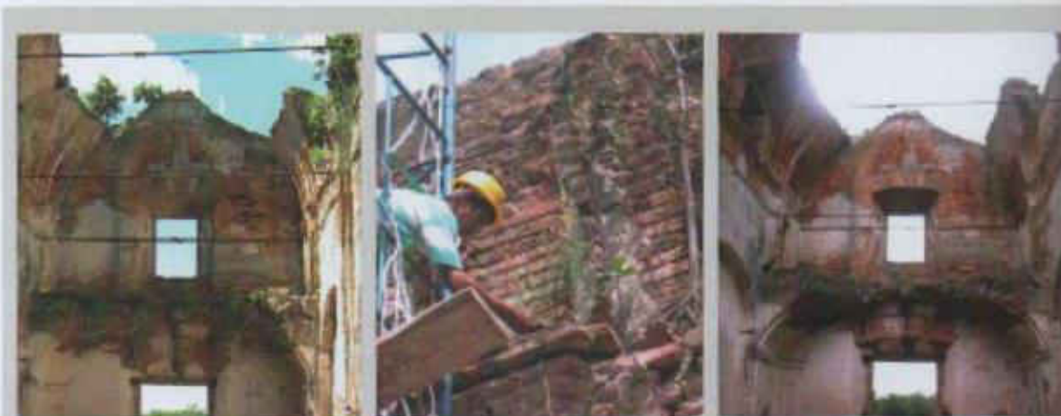
Figura 6.10 Erradicación de vegetación de gran porte en Capilla de Calera de las Huérfanas, Carmelo, setiembre de 2009. Vistas del estado previo, realización y resultado del tratamiento.
