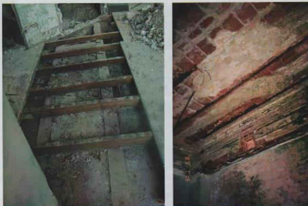
Figura 3.32 Vista superior e inferior de entrepiso de bovedilla cerámica sobre viguetas metálicas. Palacio Gandós, Montevideo.
