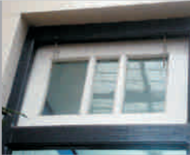
Elementos móviles, bisagras en horizontal, cadenas de sujeción y pieza de cierre y sujeción
