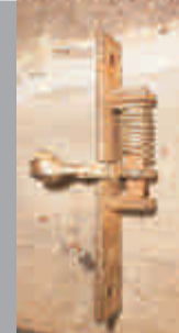
Bisagras tipo libro sujeta con tornillos
