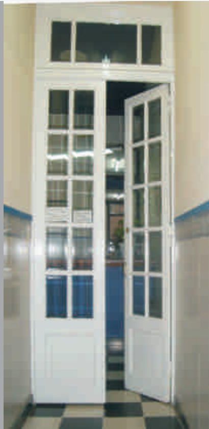
Puerta tablero doble hoja y vidrio repartido y banderola, accionamiento con sistema de cadena.
