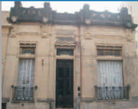
Frente con terminación fratasada y de rigurosa geometría. Presenta guirnaldas superiores con figuras antropomorfas que se destacan.
