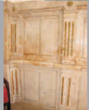
Plano de carrara combinado con detalles geométricos denifidos en ónix
