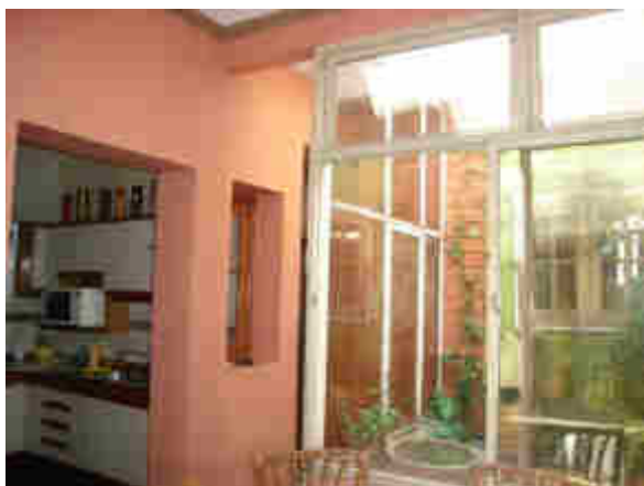
Vivienda. Compartimentación de los ambientes, pérdida de la concepción espacial originaria.
