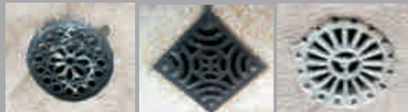
REJILLAS HIERRO PARA VENTILACIÓN DE PISOS SOBREELEVADOS UBICADAS EN LOS FRENTE HIERRO 11/12 CM DE DIÁMETRO O LADO
