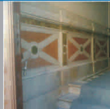
Diseño de gran complejidad sobre el material pétreo que combina tres mármoles diferentes. Predomina el color en la composición así como el importante trabajo realizado en el relieve con múltiples molduras
