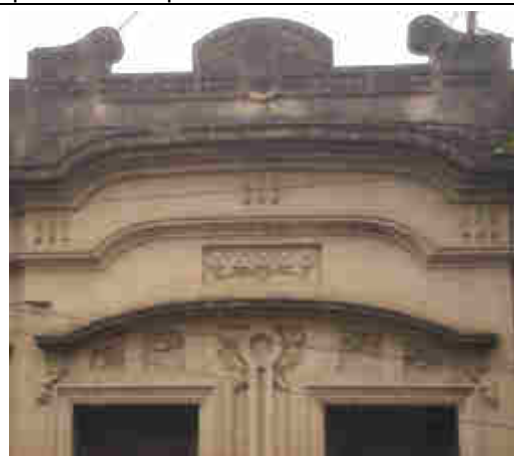
Imag. 19. Superficie lavada y con cambios en el plano para exhibir la ornamentación
