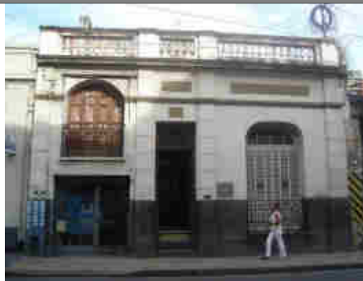
Vivienda-Consultorio médico. Local comercial. Chacabuco 82
