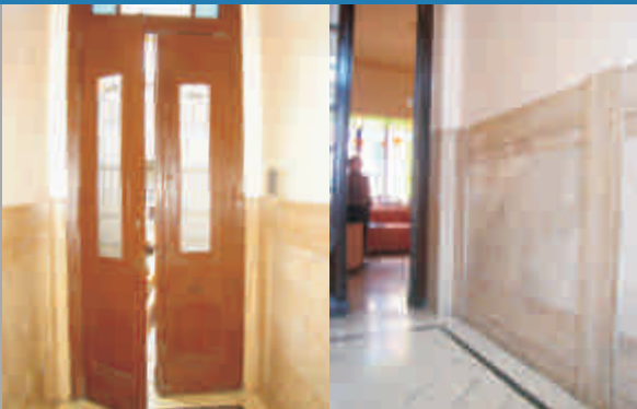
Piezas de travertino dispuestas de manera regular, se plantea el cambio de la veta como parte del tratamiento
