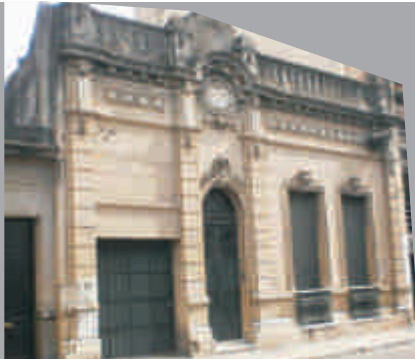
Ecléctico, almohadillado lateral remarcando los cuerpos del edificio. El perfil se presenta ornamentado donde se destaca el trabajo en los arcos y claves con un mascarón central.
