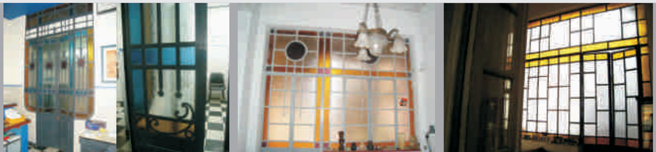
Mamparas con diseño geométrico, puerta doble hoja central y vidrio martelé incoloro, ámbar, azul y bordeaux. En la siguiente, puerta doble hoja lateral
