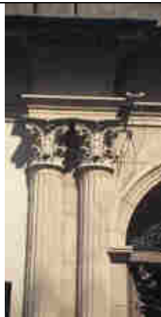
Imag. 18. Paño soporte fratasado con rehundido que simula la junta entre piedras. Los elementos centrales son las pilastras corintias Las Heras al 200
