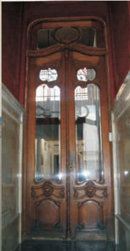
Puerta tablero doble hoja de líneas orgánicas. Sector superior, vidrio biselado y banderola. Importantes relieves y tallado de la superficie.
