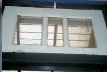
Elementos móviles, bisagras en horizontal, cadenas de sujeción y pieza de cierre y sujeción
