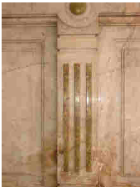
Imag. 36. Revestimiento en zaguán con diversas manchas, 25 de mayo 470. Se enuncia posibles orígenes y se proponen acciones.
