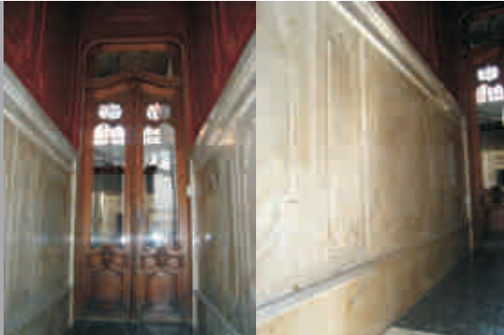
Piezas de carrara con importante trabajo de labrado y molduras definen un diseño curvilíneo hacia el interior del plano
