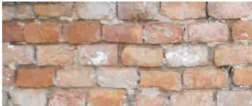
Muro de ladrillo común cocido de 0, 45 m tomado con mortero de barro, corresponde a principios del XX. Se observa la irregularidad de la junta así como del ladrillo.
