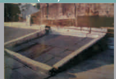
Pluviales, canaleta de chapa doblada y desagües de hierro fundido embutido. Cubierta de chapa, resolución modular pendiente a un agua
