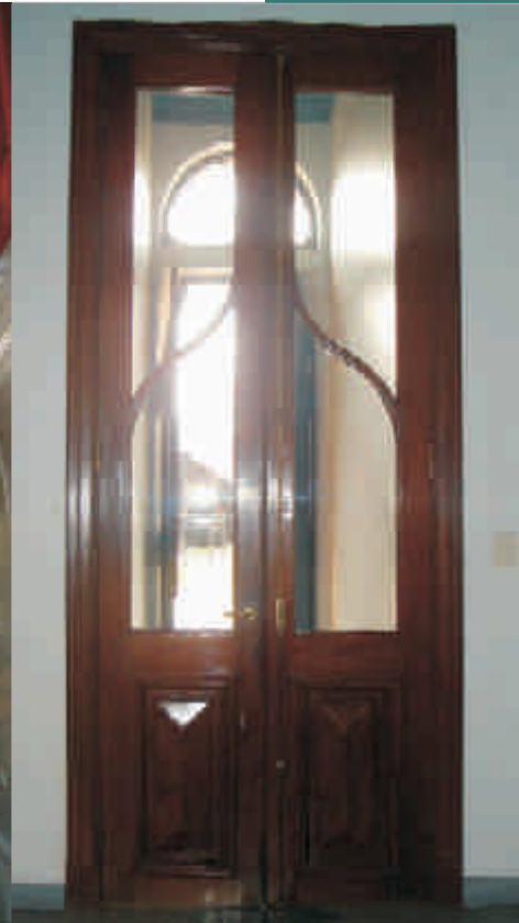
Puerta tablero doble hoja de líneas orgánicas. Sector superior de vidrio. Tablero diamante.
