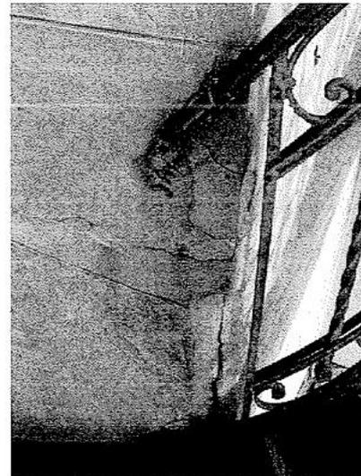
61 – Vista de marcas de corrosión por elementos metálicos en el revoque
