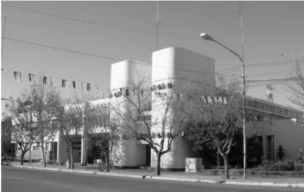
Fig.53: Actual edificio Municipal
