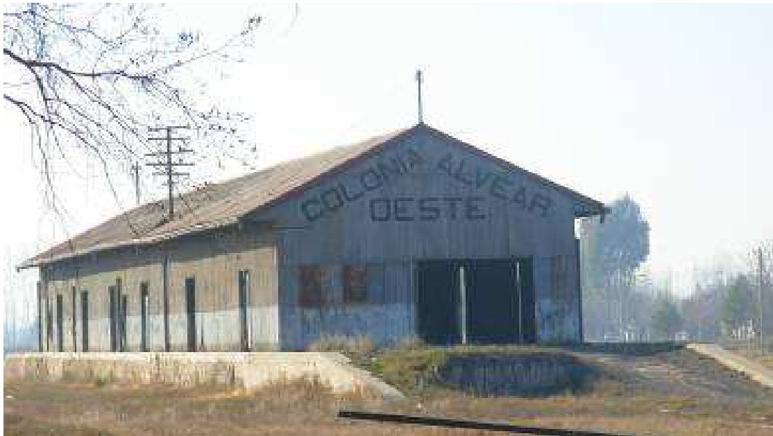
Fig.44 y 45: Estación FCOeste, en Alvear Oeste.
