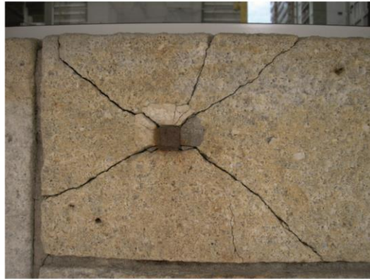
REVESTIMIENTO EN EDIFICIO Av. Luro 2179, esquina Corrientes
