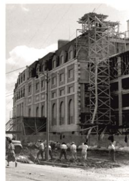
Esculturas ornamentales pétreas. Revestimiento de piedra y ladrillo en fachada. Proceso constructivo: estructura de hormigón y el revestimiento de piedra
