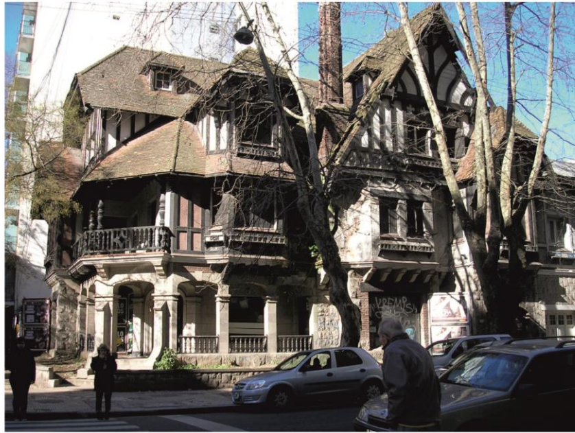
Vista general desde la calle Sarmiento
