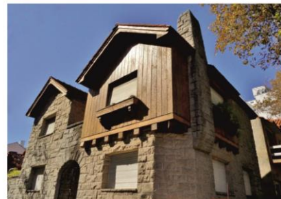
Villa Chichú, 1942. Aparejo en "bastón roto" balcón con balastrada labrada..
