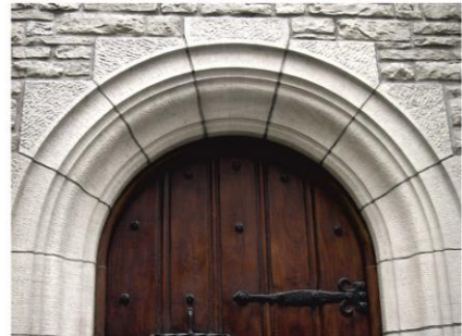
arco adovelado en acceso a vivienda Santiago del Estero 1235, Mar del Plata
