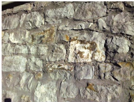
Detalle del basamento de Villa Normandy mampostería rústica con juntas enrasadas
