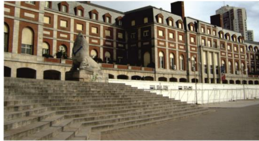
escalinatas de piedra martelinada - pináculos ornamentales en forma de obeliscos
