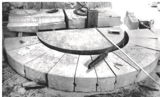
Presentación de las dovelas sobre el plano de montea
