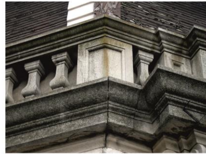
encuentro de molduras (interno y externo) Villa Kelmis Alvear 2010, Mar del Plata
