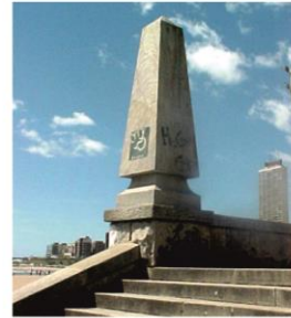
escalinatas de piedra martelinada - pináculos ornamentales en forma de obeliscos
