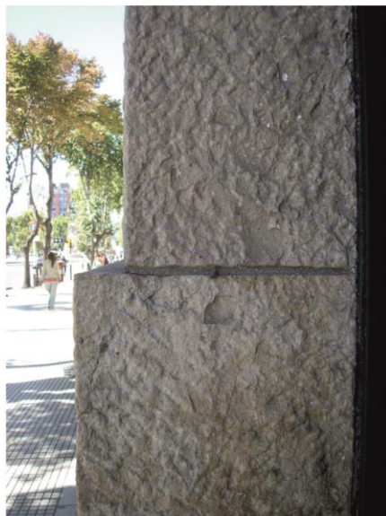
terminación superficial picado rústico
