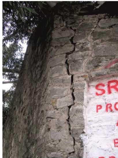
GALPÓN DE LA CANTERA G. RIZZO calle Rosales esquina Bestoso
