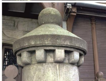
Villa Devoto, 1918 (Buenos Aires 2275). La piedra se aplica en el cerco, basamento y detalles -Detalle de cubrepilar labrado.
