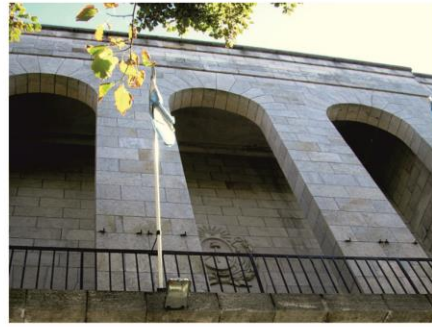
La piedra recubre las fachadas externas y las internas del pórtico de acceso, y de la loggia en planta alta
