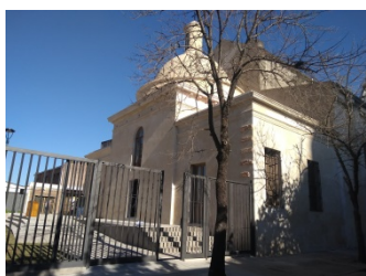
Liberación de agregados que afectaban la imagen original del edificio. Fotos A. Yonson
