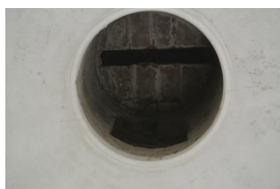
En el interior de la linterna se evidenciaban vestigio de una antigua ventana. Fotos A. Yonson
