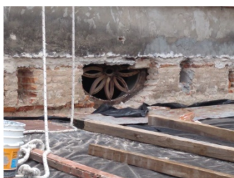
La reconstrucción de las losas de azotea en su nivel original permitió liberar a las ventanas ovals de su cegamiento. Foto A. Yonson
