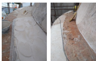
Nuevos revoques en cubiertas horizontales escalonadas eliminando parches de cemento. Fotos A. Yonson
