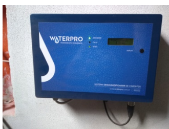
Canaletas de ventilación y equipo por electro ósmosis como tratamientos propuestos para controlar humedades ascendentes.
