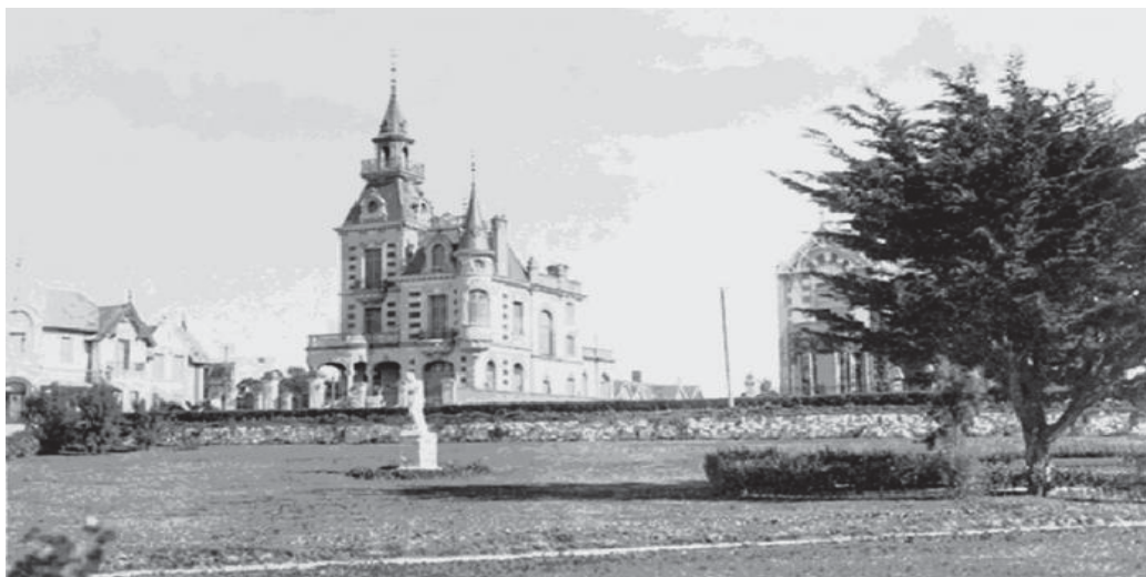
Años más tarde en el Paseo General Paz. Sobre la izquierda Villa Duggan, Boulevard Marítimo y Sarmiento, al centro el Chalet Polledo (hoy Hermitage Hotel). En 1940 fue trasladada a Plaza Colón.
