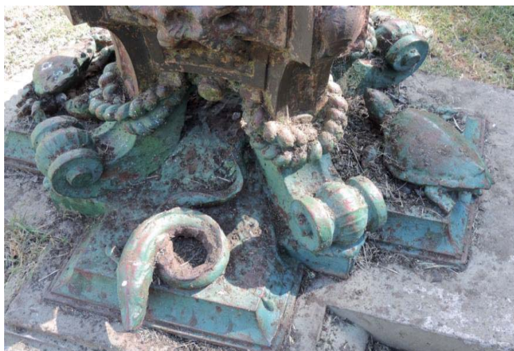
Fotos antes de la restauración
